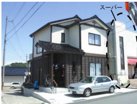
写真4 道下集落の自己所有地提供型災害公営住宅の外観
