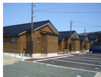
写真3 松風台災害公営住宅の外観
