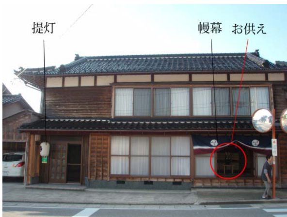
図2-1 通りからのファサード写真
